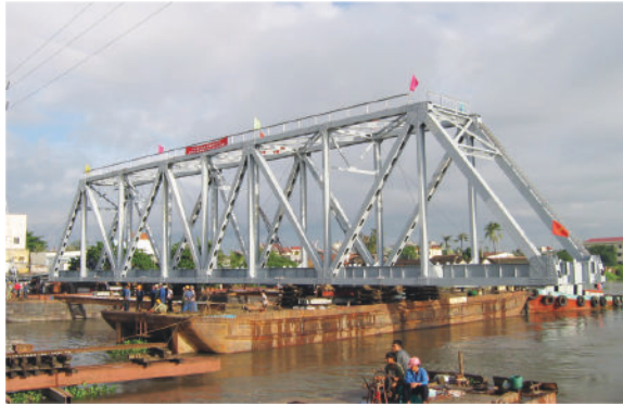
采用浮船技术施工统一铁路线1719+860公里处平利桥
