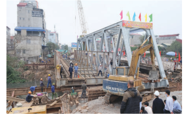
施工嘉林-海防铁路线19+100公里处如琼桥I
