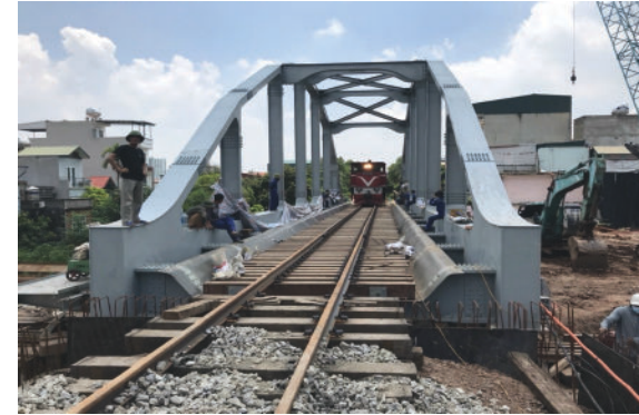
施工河内-凉山铁路线4+450公里处玉瑞桥
