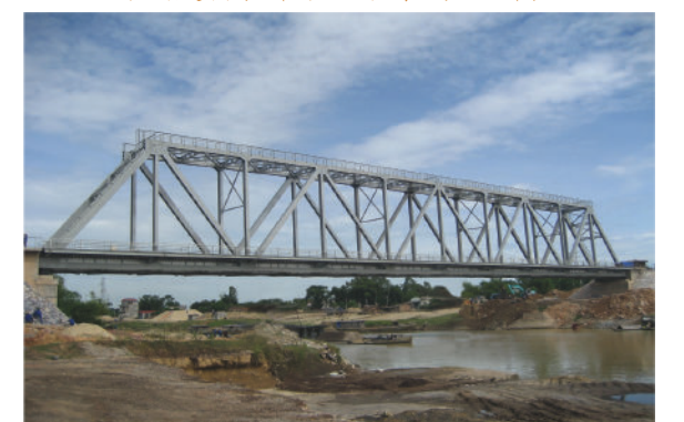
施工东英-馆潮铁路线20+202公里处多福桥，采用越南铁路最长梁跨（110米）
