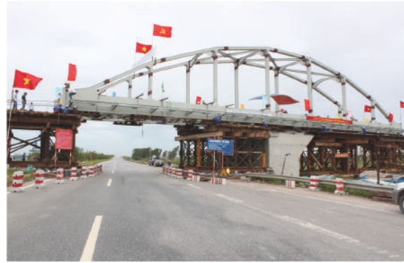
施工安园-普赖-下龙-盖麟铁路项目15+071公里处桥梁
