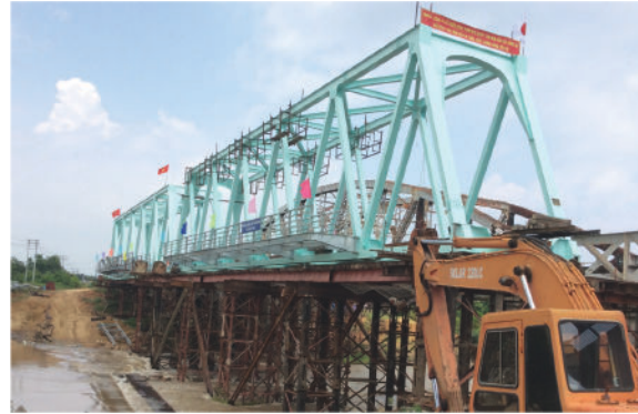
施工CP3c项目水垒江桥
