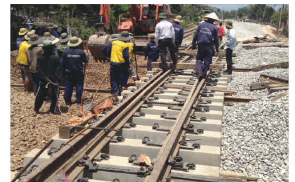
施工安装高速道岔，属于更换K1、K2混凝土枕及铁枕为预应力混凝土枕，延长站线，为仅有两股道的车站增设第3股道项目
