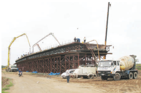
施工西贡-忠良高速公路项目跨线桥
