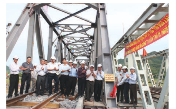
根据政府总理紧急命令，施工罗海桥
