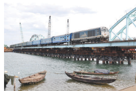
施工统一铁路线薄弱桥梁升级项目CP2标段各项工程
