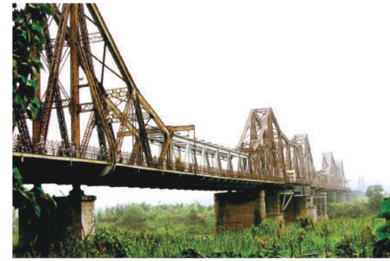
加固河内市龙边桥
