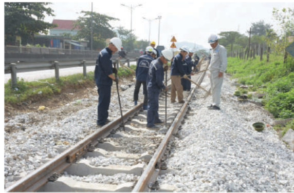
施工XL-HNV-05标段：升级市夷车站、荣车站站台及雨棚；升级改造从长林至荣（Km237+790-Km 319+020）区间
