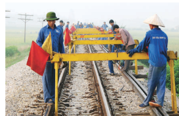
在统一铁路线175-185公里段铁路施工中应用长钢轨焊接技术
