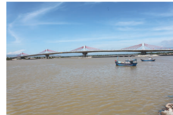
施工宁顺省安东斜拉桥
