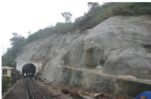
采用干喷混凝土技术加固海云关铁路
