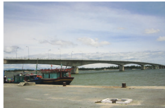
施工广治省葛港口桥，120米长悬臂浇筑跨
