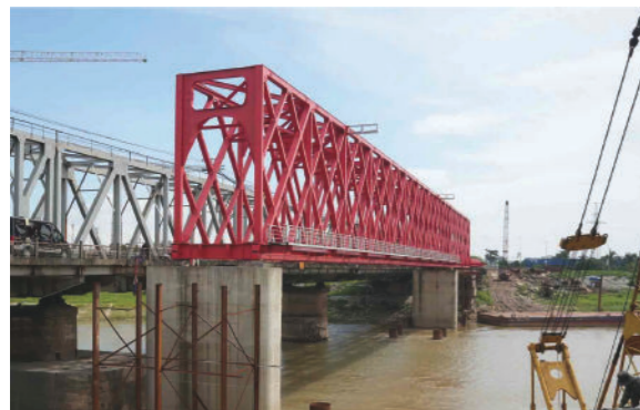
施工河内市墩河铁路桥
