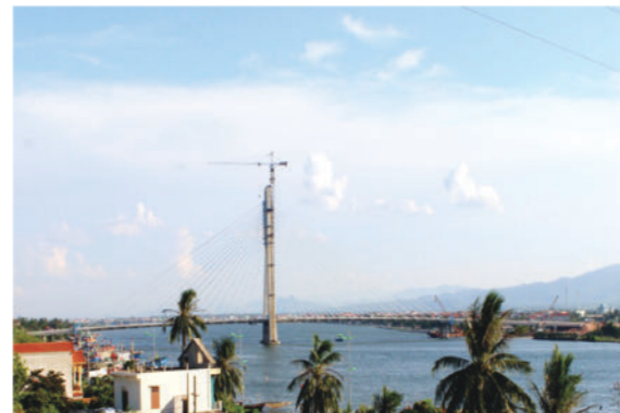
施工广治省日丽二桥
