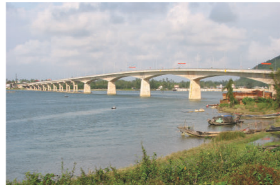
采用悬臂平衡浇筑技术施工顺化市思贤桥
