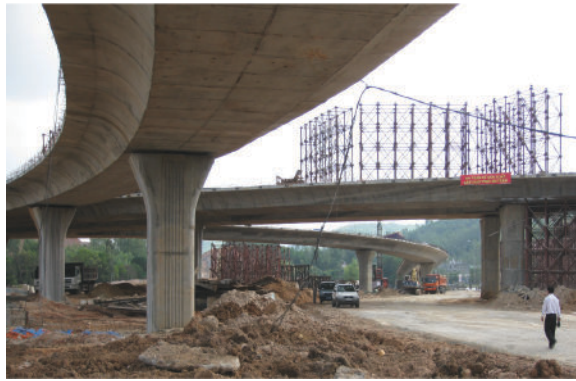
施工下龙-盖麟项目CV1、CV2匝道桥
