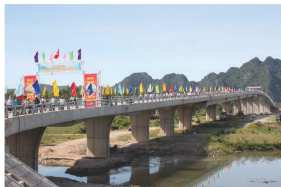
施工广治省跨笋河文化桥
