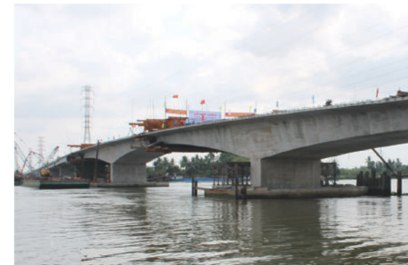
施工同奈省同奈桥
