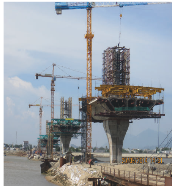
塔式起重机 Tower crane
