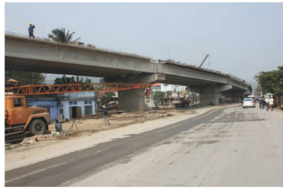
根据总理紧急命令，施工统一铁路线982+981公里处铁路跨线桥
