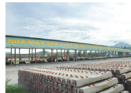
岷港轨枕及钢筋混凝土构件生产厂
