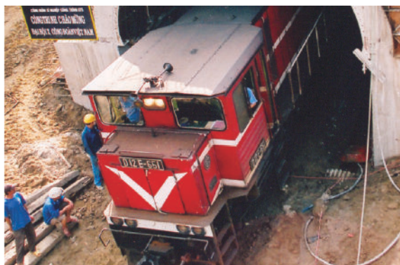
根据政府总理紧急命令，施工将13号隧道延长50米
