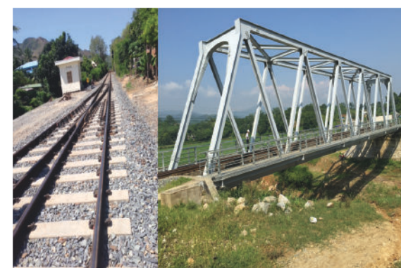
施工安园-老街铁路线升级项目CP3标段
