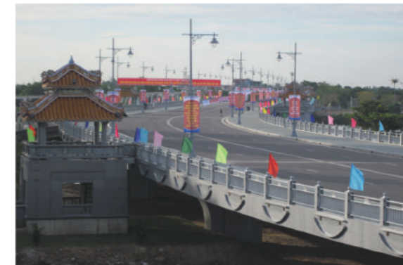
施工顺化市白虎桥
