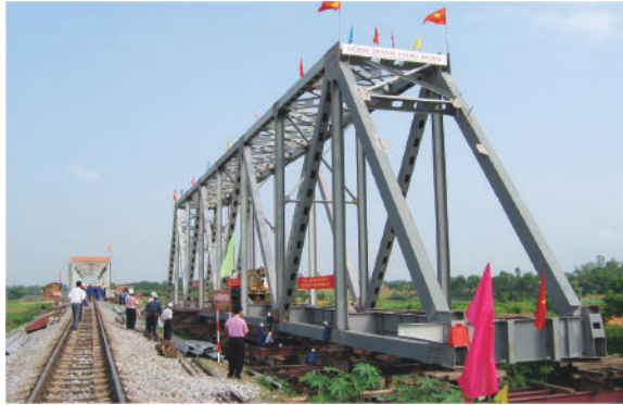
施工河内-铺卢铁路（永福省段）42+272公里处盛记桥
