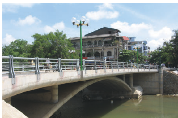
施工顺化市御泊桥
