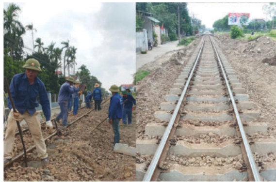
施工第9号标段：施工广治省、顺化市部分线路段的路基改造升级及上部建筑
