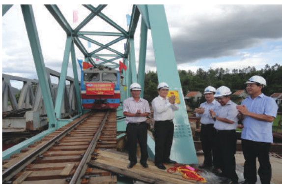
施工富安省柑桥，属CP3C标段工程
