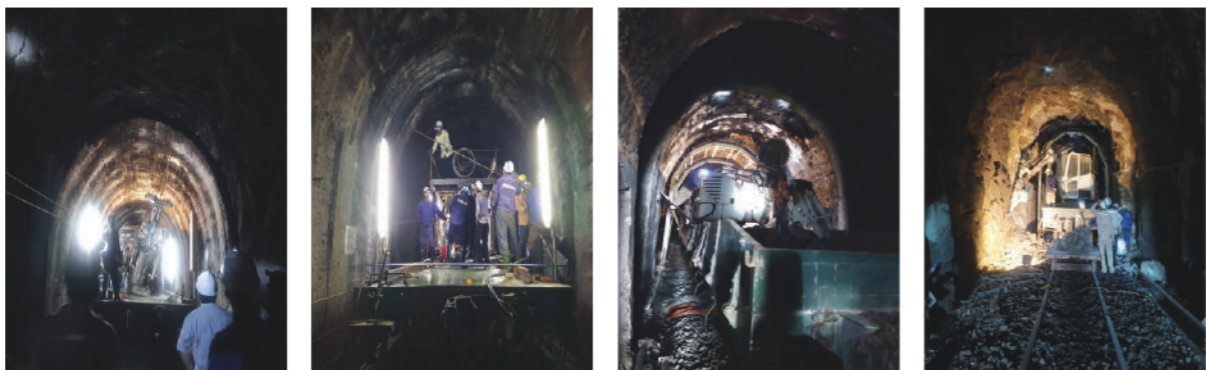
第12号标段：施工Babonneau隧道加固工程项目
