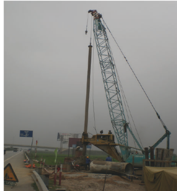
Máy khoan cọc nhồi Kobelco BM500 Kobelco BM500 rotary drilling rig
