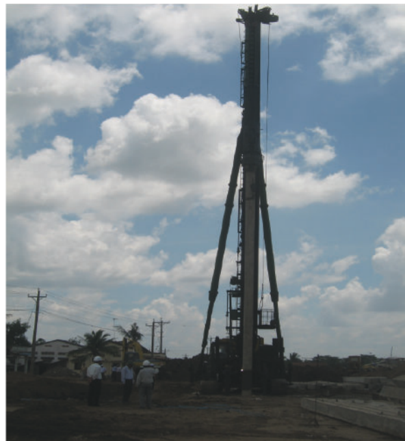
Máy đóng cọc Pile driver
