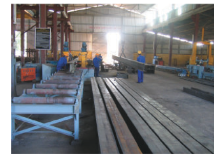
Xưởng chế tạo dầm và kết cấu thép, công nghệ hàn tự động tại Huế
