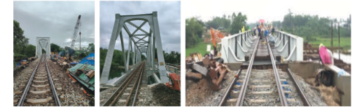
Cầu Km 939+419 Cầu Hói Rui Km 750+350 Cầu Km 865+610
