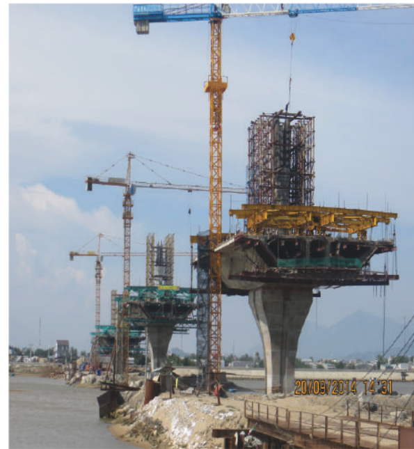
Cầu tháp Tower crane
