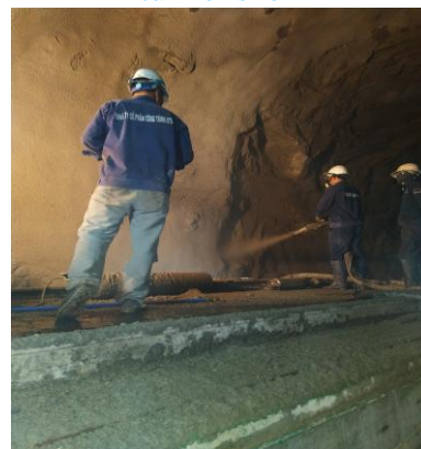
Phun vữa bê tông tạo vỏ hầm Spraying concrete mortar to create tunnel shell
