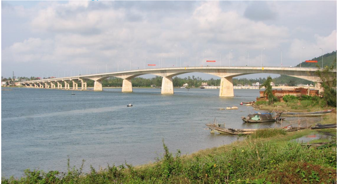
Thi công cầu Tư Hiền, tỉnh Thừa Thiên Huế bằng công nghệ đúc hẫc cân bằng Construction of Tư Hieu Bridge, Thua Thien Hue Province, Using Free Cantilever technology
