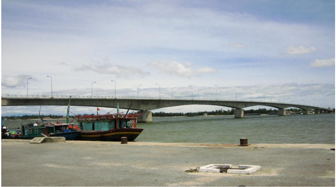
Thi công cầu Cửa Việt, nhịp đúc hẫng dài 120m, tỉnh Quảng Trị Construction of Cua Viet Bridge, With Cantilever span of 120m, Quang Tri Province
