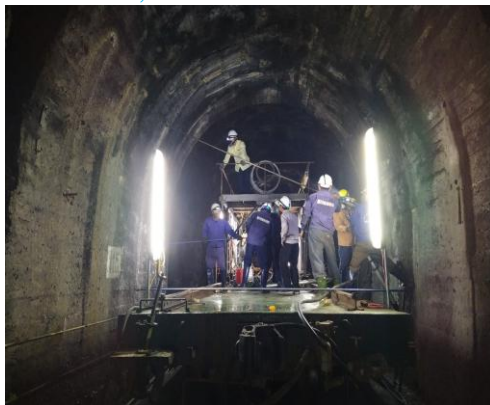
Phá dỡ vỏ hầm cũ Demolition of the old cellar
