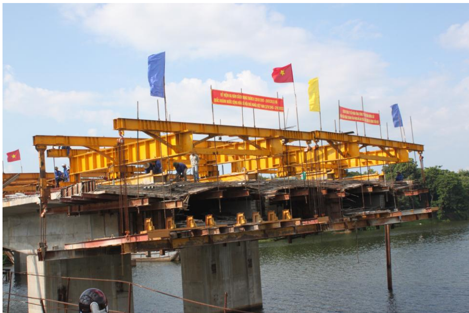
Xe đúc hẫng – Cantilever truck
