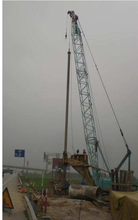
Máy khoan cọc nhồi Kobelco BM500 Kobelco BM500 rotary drilling rig
